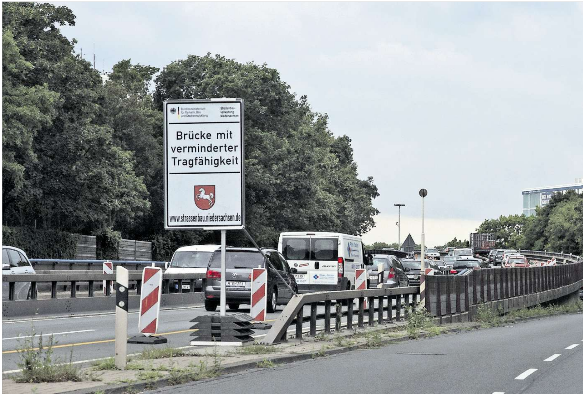
Die Südschnellwegbrücke konnte die Verkehrslasten nicht mehr tragen, deshalb wurden zwei Fahrspuren gesperrt.
